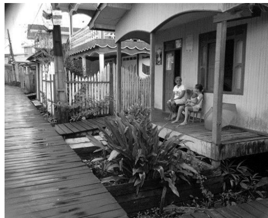
Figura 10. Varandas em Afuá: espaços de transição suaves (fonte: autores).
