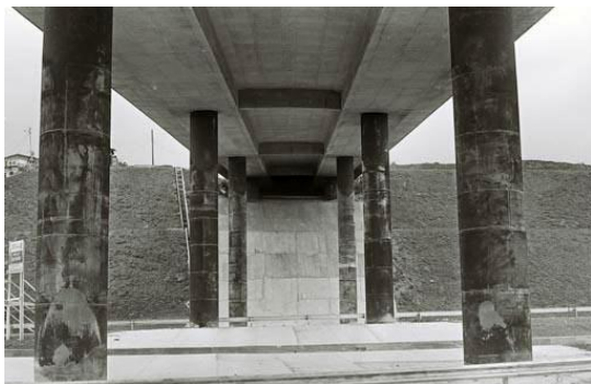
Figura 15. Viaduto Cangaíba, 1986 (fonte: Acervo Museu da Cidade de São Paulo).
